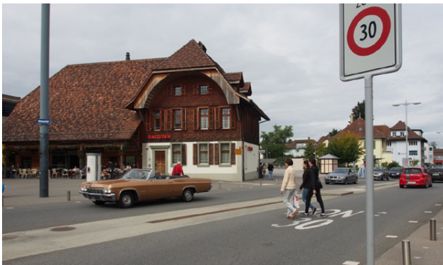
Abb. 14: Schwarzenburgstrasse Köniz (BE) Die Hauptstrasse im Ortskern von Köniz wurde in eine Tempo-30-Zone benachbarter Quartierstrassen integriert und erlaubt so flächiges Queren.
