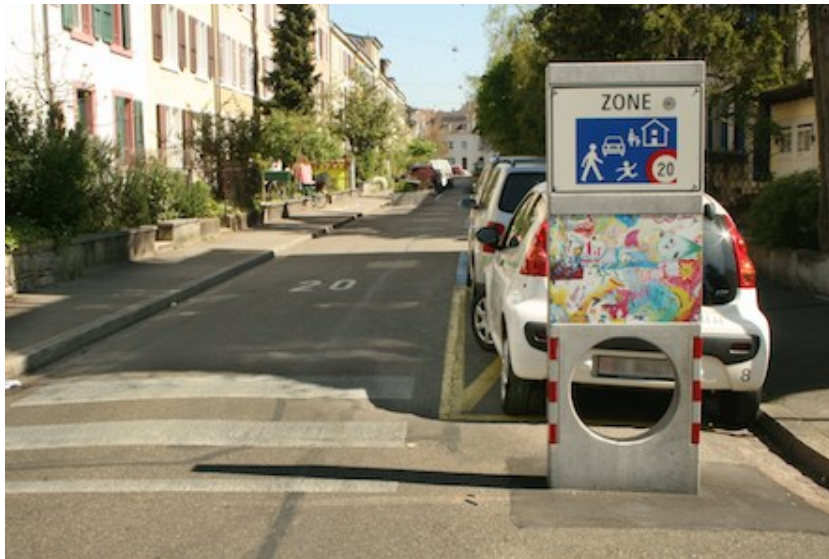
Abbildung 2: Beispiel einer Standard- einfahrt mit Torelement, Verkehrsschild, Kinder- zeichnung, sicht- und spürbare Dreistreifen- markierung sowie Mar- kierung „20“.
